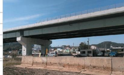
日本躯体処理が開発したけい酸塩系表面含浸材「RCガーデックス 土木用(1回塗り)」は従来技術に比べ工程の簡略化が可能となった製品。従来技術では施工表層部の水分調整ならびに塗布後の散水による湿潤養生が必要<sup>\*1</sup>であった。工程数が多いことや周辺環境によっては散水が困難であるケースもあり、施工者の負担となる場合があったが本製品では従来の2回塗布から1回塗布に変更。材料塗布前の施工面の水分調整ならびに塗布後の湿潤養生を不要とすることでも、本来の保護効果を保持しつつ施工時間自体を大幅に短縮。施工コストも約65%に低減(同社比)。これにより間接的な経費(仮設費や交通規制など)の削減にも貢献できる。
