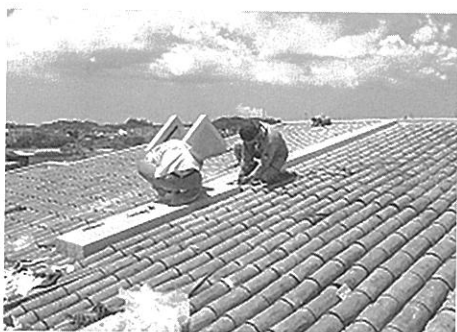
写真2 防錆強化剤および塩害用の流し込み
