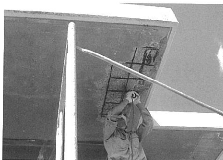
写真3 浮いた箇所のはつり
