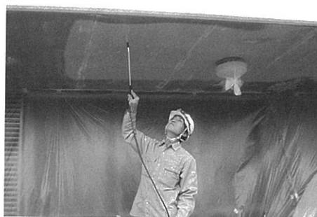
写真4 防錆強化剤および塩害用の散布
