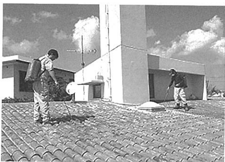
写真1 防錆強化剤および塩害用の散布
