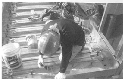
写真2 コンクリート打設前のデッキ処理
