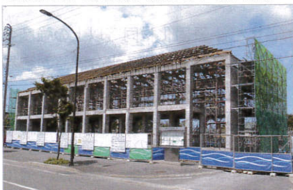
●黒松内町庁舎(北海道・築58年)での施工風景
