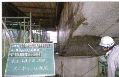
●熊本港大橋橋梁補修工事時の施工風景
