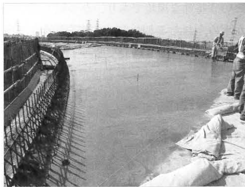
写真-2 施工完了
