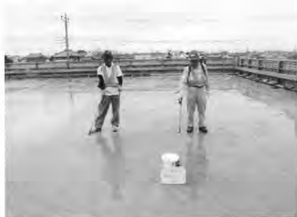
写真-3 散水・養生
