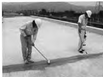
写真-4 仕上げ・清掃
