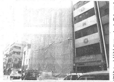
ビルのイメージを左右する外壁
