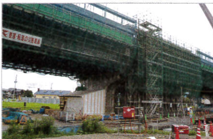
●北陸新幹線の施工風景
