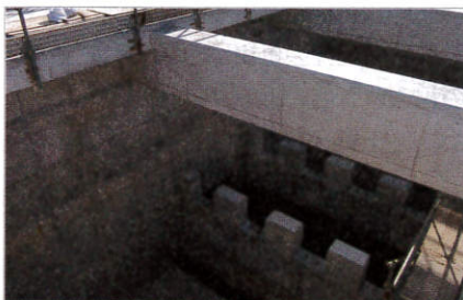
●浄水場の施工風景
