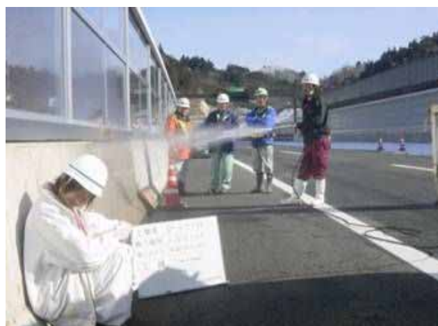
第3次散水及洗浄
