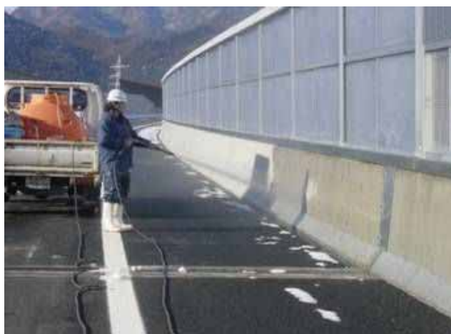
洗浄及第1次散水
