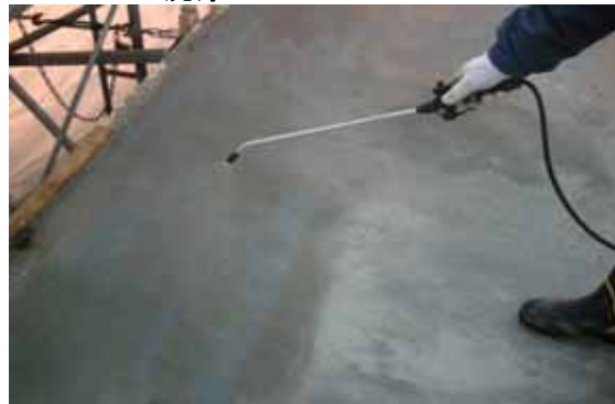
RCガーデックス塗布1回目
