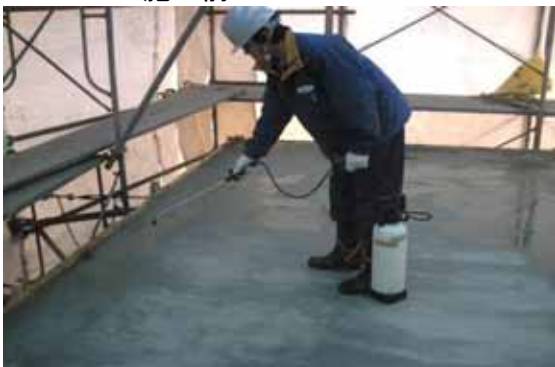
RCガーデックス塗布1回目
