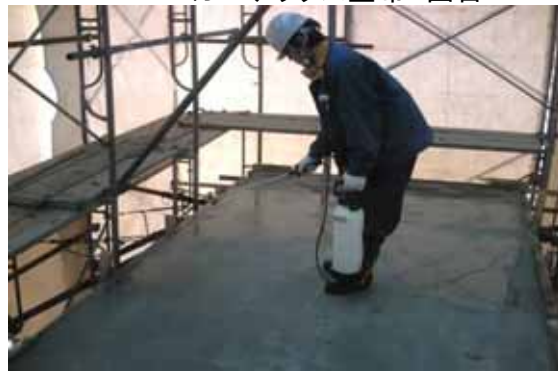
RCガーデックス塗布2回目
