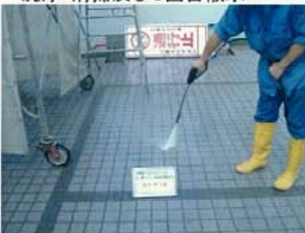
洗浄・清掃及び3回目散水
