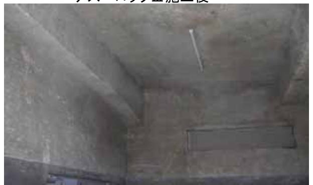
アスベロックⅢ施工後
