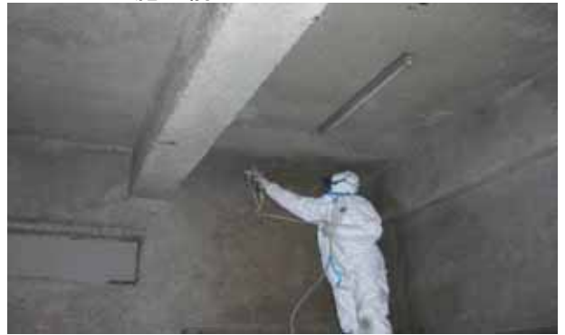
アスベロックⅢ施工中
