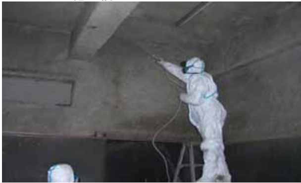
アスベロックⅢ施工中
