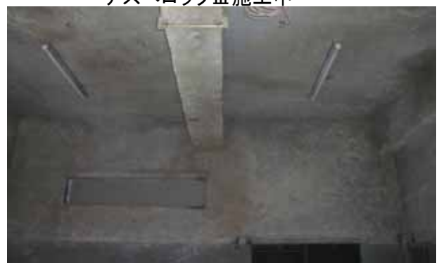
アスベロックⅢ施工後
