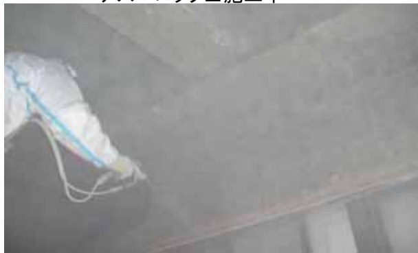
アスベロックⅢ施工中
