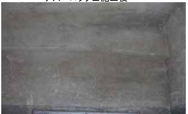
アスベロックⅢ施工後
