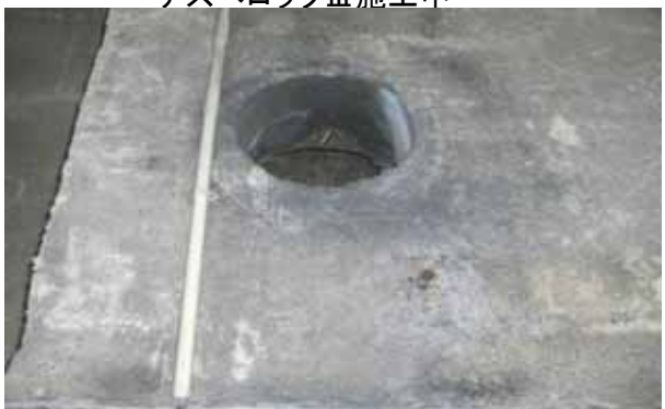
アスベロックⅢ施工後
