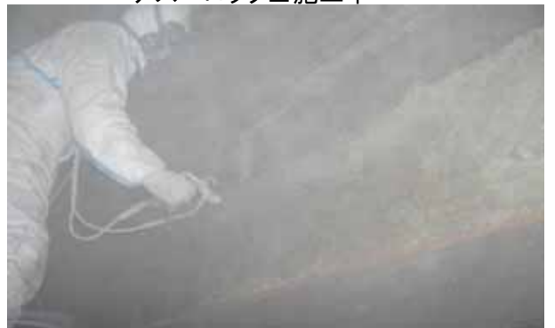
アスベロックⅢ施工中
