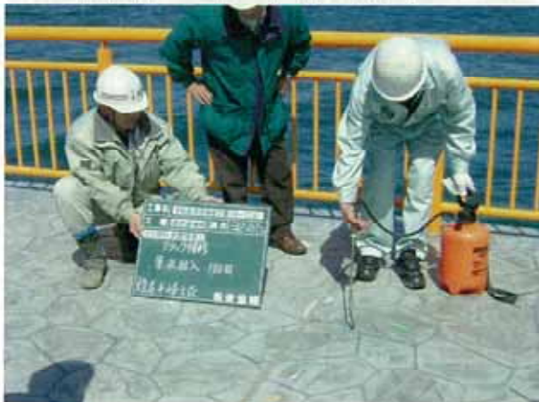
【2回目 RCガーデックス施工】
