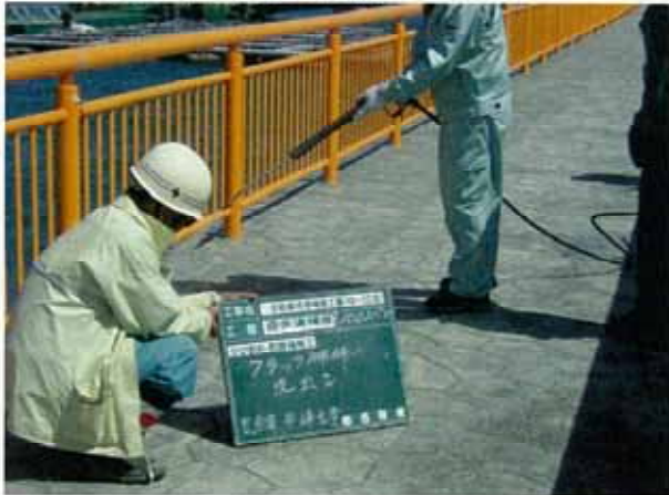
【施工面 洗浄作業】
