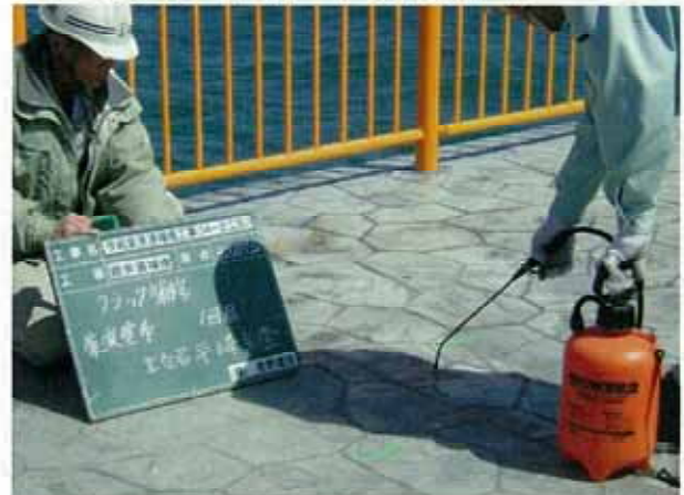
【1回目 RCガーデックス施工】
