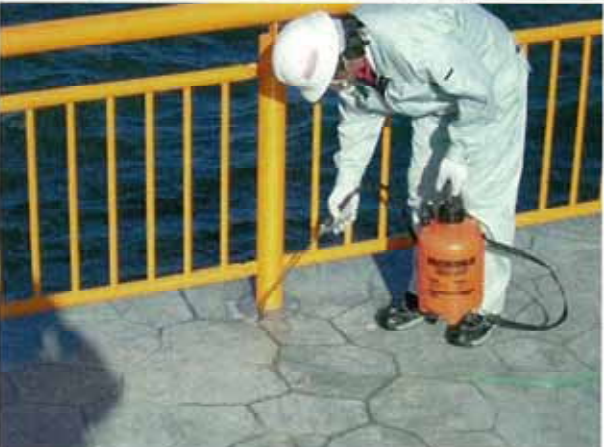
【2回目 RCガーデックス施工】
