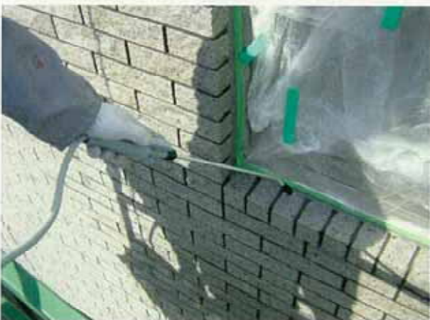
【RCガーデックス施工】
