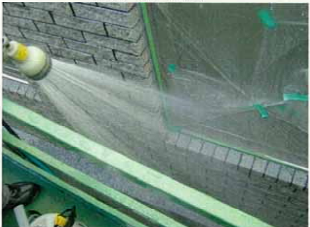
【洗浄・散水作業】
