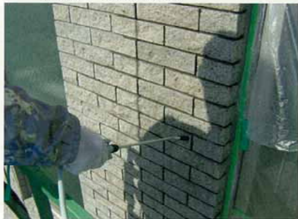
【RCガーデックス施工】
