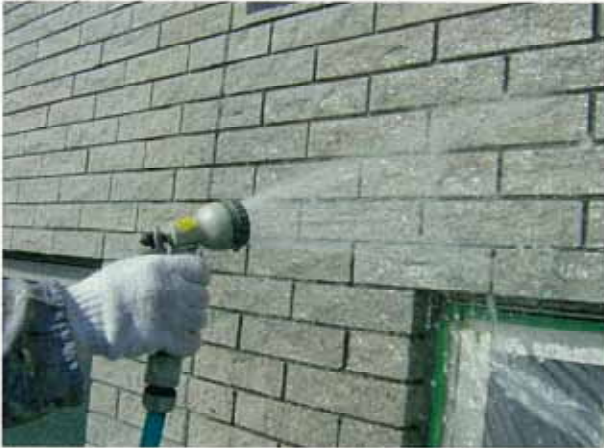
【洗浄・散水作業】
